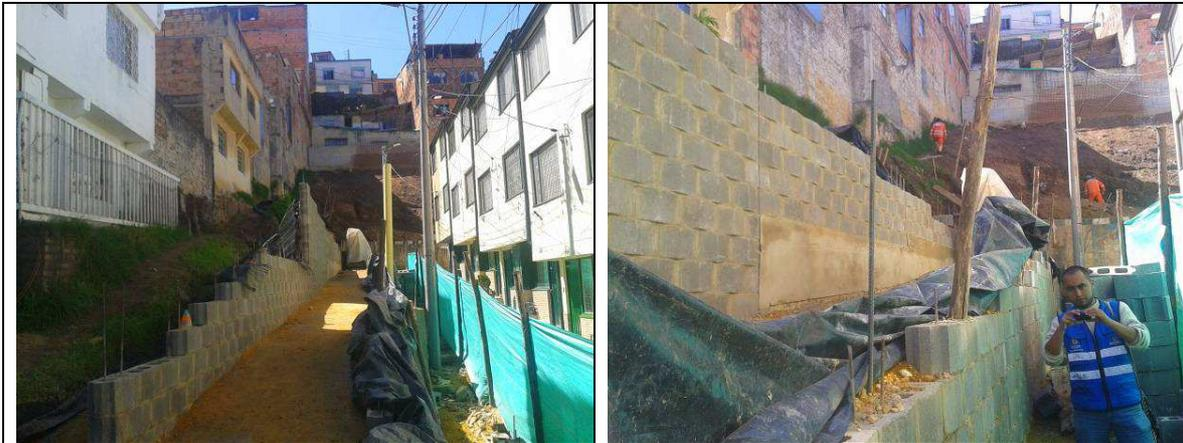
Sobre la transversal 16F se observan los trabajos de implementación de muros en geobloques y la conformación de senderos peatonales.
