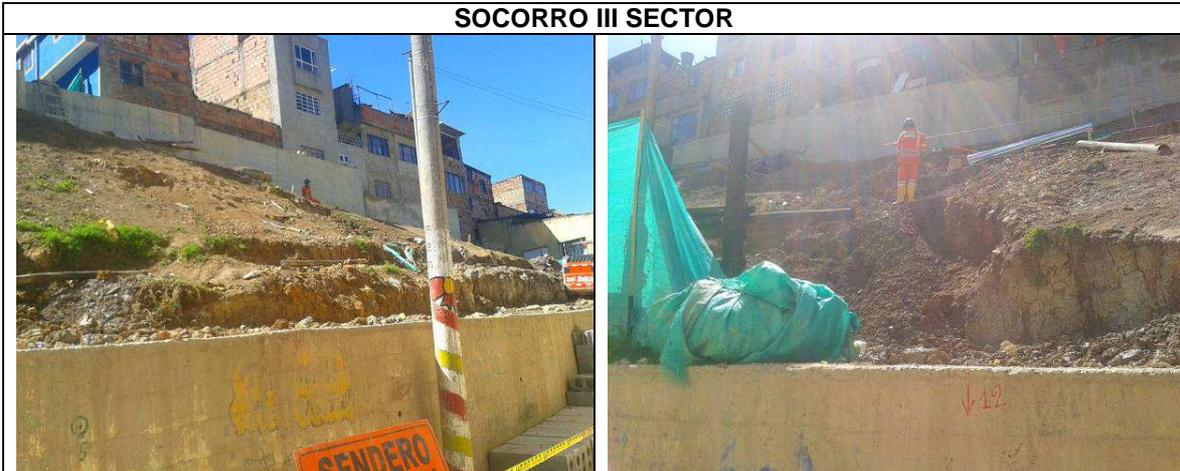
Estado de las obras de mitigación sobre la Diagonal 49B sur. Se observa la construcción del muro de contención en la parte superior y se adelantan trabajos de conformación de los senderos peatonales.
